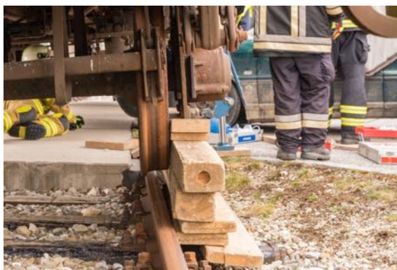
Abbildung 43: Sichern eines angehobenen Fahrzeugs durch Unterbau
