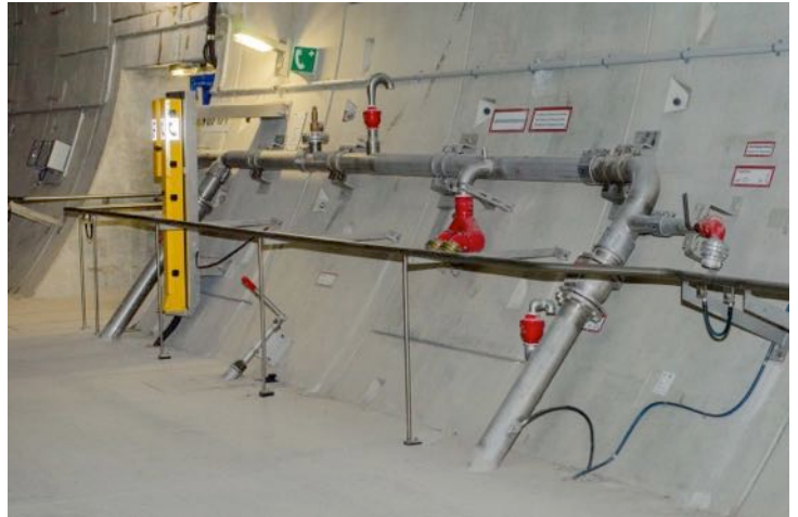
Abbildung 57: Überleiteinrichtung Löschwasserleitung (Beispiel)
