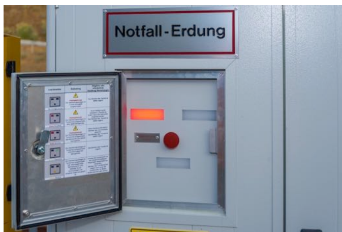
Abbildung 13: Leuchtmelder und Nottaster einer OLSP
