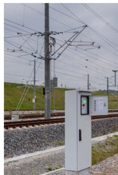
Abbildung 14: Bedienschrank einer OLSP
