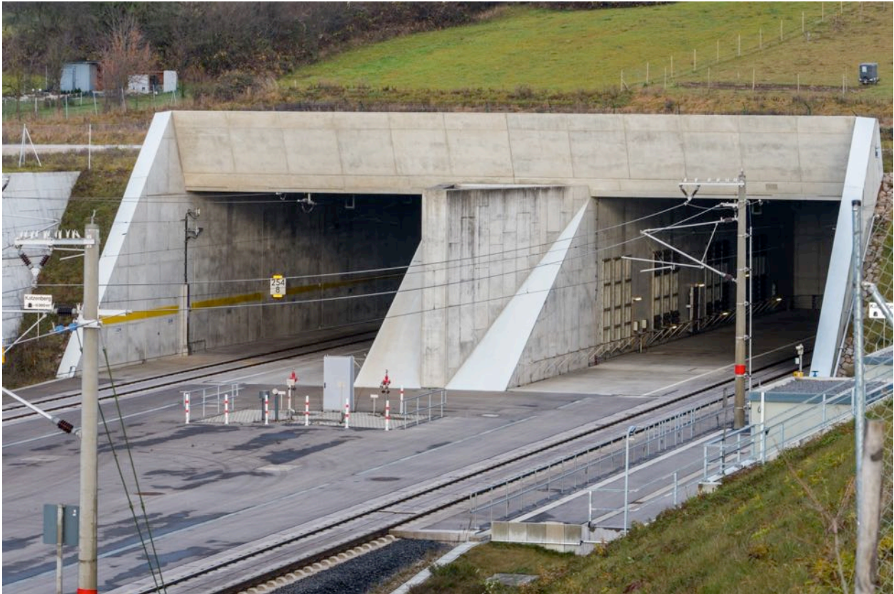
Abbildung 47: Südportal des zweiröhrigen Katzenbergtunnels
