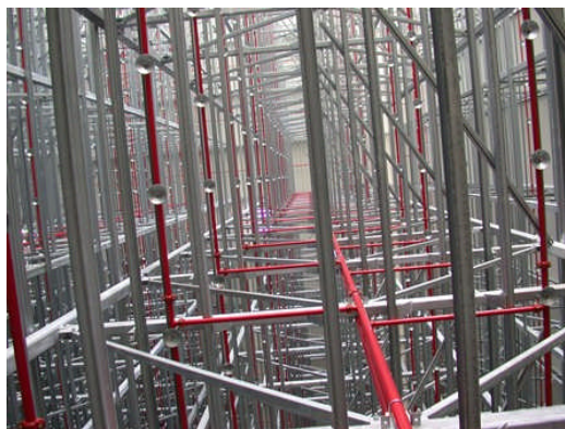
An den roten Leitungen sind die Sprinkler gut zu erkennen. (Foto: A. Rother)
