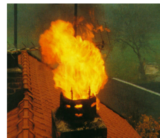
Bild 1: Offenes Flammenbild am Schornsteinkopf
