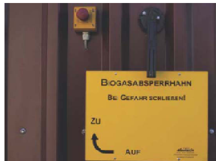
Bild 4: Gasabsperrhahn einer Biogasanlage
