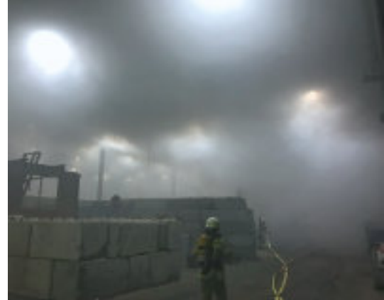
Stark verrauchte Halle des Recyclingunternehmens
